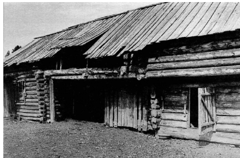
Фото 8. Срубные хозяйственные постройки в «замкнутой» усадьбе (Иглинский район, 50-е годы XX в.)
